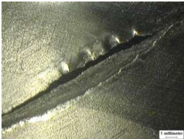
Fotografía N° 3.- Grieta con pliegues y laminación.
