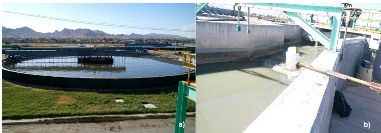
Figura 1.- a) Sedimentador primario de la PTAR Sur; b) Toma de muestra en la caja de distribución.
