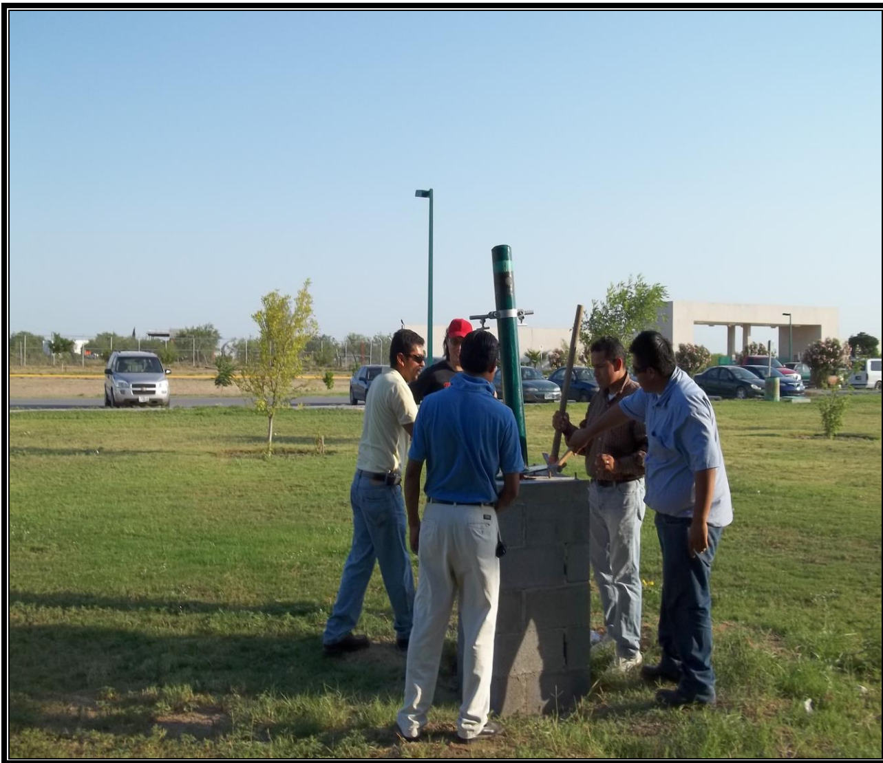
Grafica 3.3. Fotografía que muestran los Alumnos que realizan el montaje de instalación de Sistema didáctico FV
