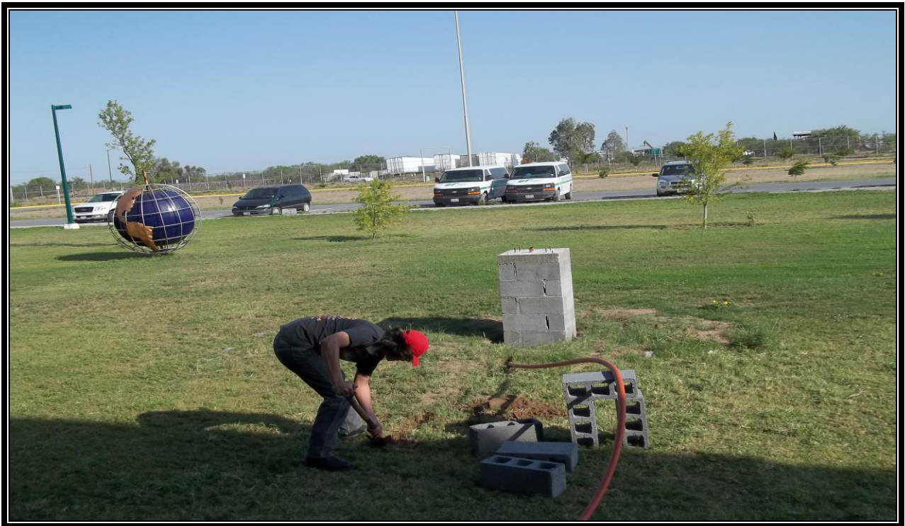
Grafica 3.1 Fotografía que muestra la preparación de para Instalación de PV
