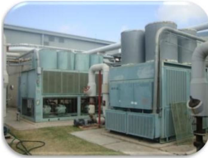
Figura 31.- Equipo (chillers), que suministra agua al proceso de inyección
