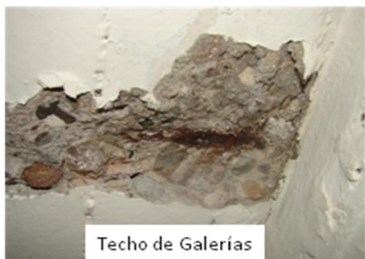
Foto1. Deterioros encontrados durante la inspección
