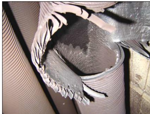
FIGURA 2. Vista general de la falla ocurrida. Observe la gran deformación que presenta el tubo afectado.
