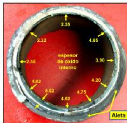
FIGURA 10. Huella de la sección transversal 3 mostrando valores de espesor (mm) de depósito interno en varios puntos.
