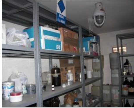
Figura 18. Interior del almacén de residuos peligrosos. (Vista 1).
