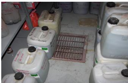
Figura 24. Rejilla de desagüe en almacén de residuos peligrosos.
