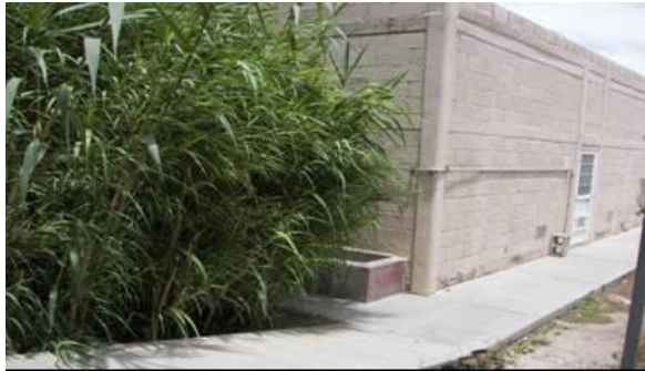
Figura 11. Edificio del almacén temporal de residuos peligrosos.
