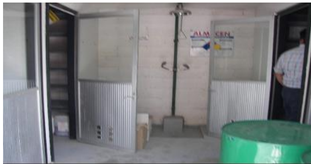
Figura 17. Interior del edificio del almacén temporal.
