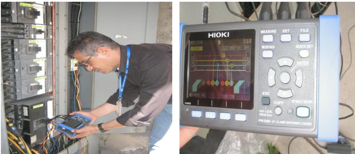
Imagen 5.7 Pruebas con un Analizador HIOKI PW 3360
