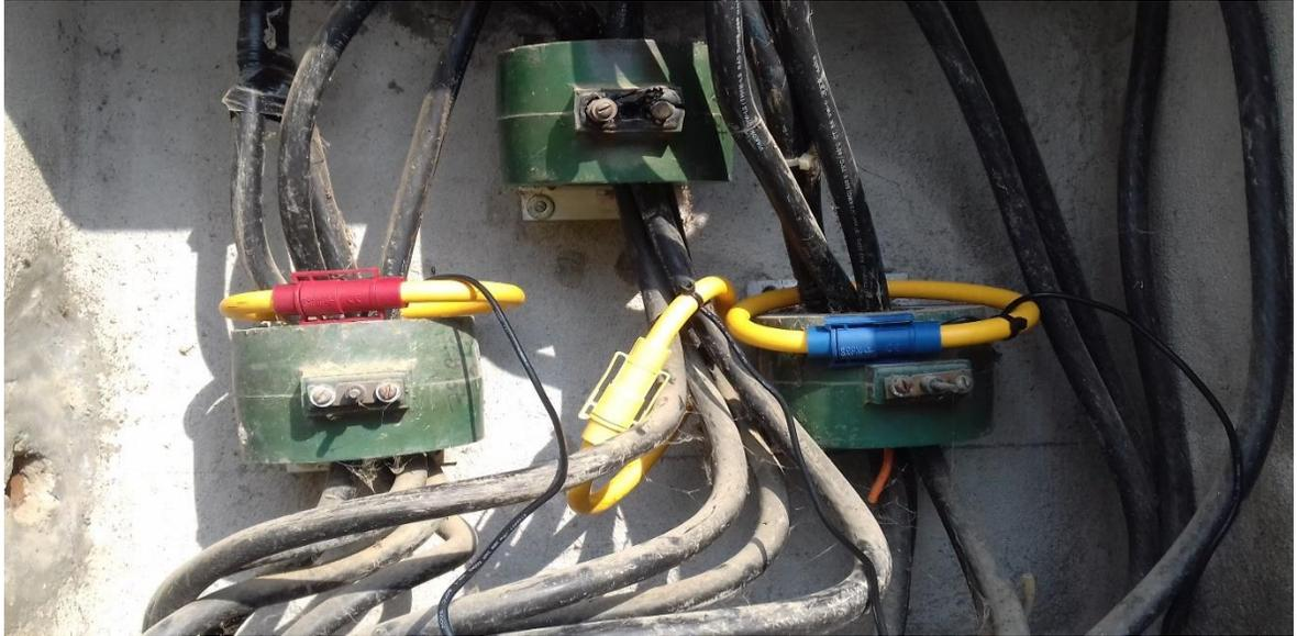
Ilustración 6.4 Abrazadera dañada por sobrecalentamiento.
