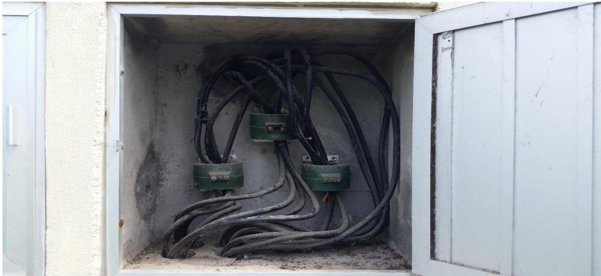
Ilustración 6.1 Cacle del calibre 4 / 0 usado en la subestación 1.
