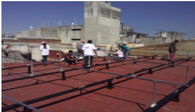
Figura 13 Nivelación del piso
