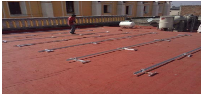
Figura 12 Colocación de bases para montaje de panel
