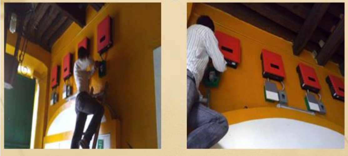
Figura 15 Instalación de 4 inversores marca KLNE modelo sunteam 1500
