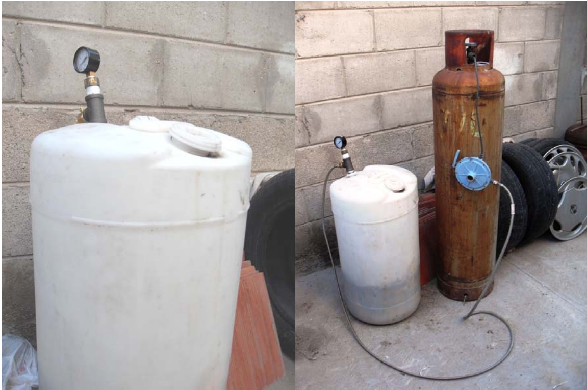
Biodigestor con manguera conectada a un tanque de gas para almacenar el biogás que se genere.
