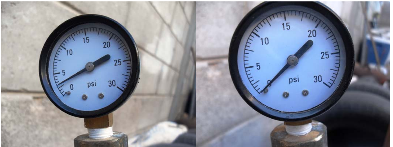
Manómetro indicando la presión antes y después de haber colocado la manguera hacia el tanque de gas
