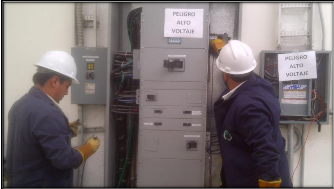
Ilustración 1: Revisión de la instalación eléctrica del local
