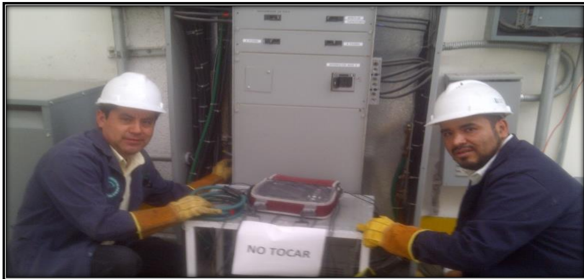
Ilustración 2: Colocación del analizador de redes
