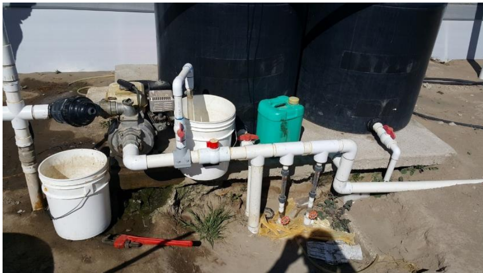
Figura 29. Sistema de riego y bomba (5 HP) del invernadero 1.
