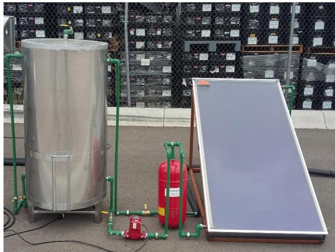
*Figura 5: Un termo tanque y su conexión básica*
