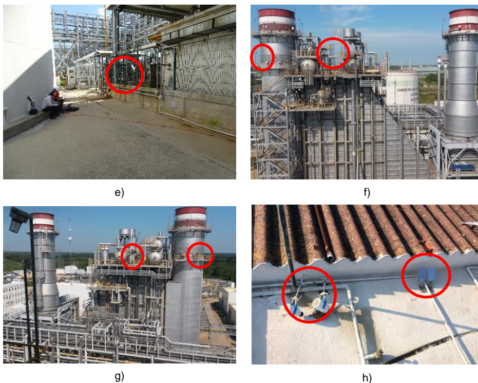
Figura 8. a) Techo sub-estación; b) Caja de filtros unidad 1; c) Caja de filtros unidad 2; d) Techo cuarto de control; e) Reja de gases; f) Domo y Chimenea unidad 1; g) Domo y chimenea unidad 2; h) Blanco, en la ciudad de Villahermosa, Tab.
