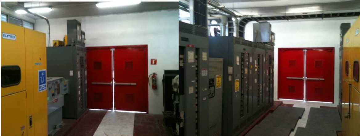
Imagen 3.3, Subestación 2 en planta alta.
