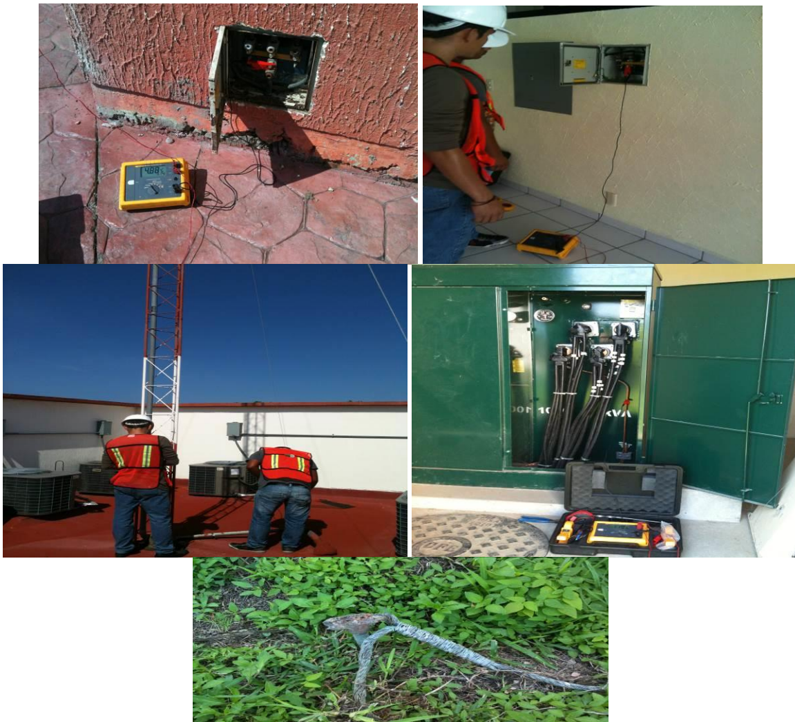
Imágenes 3.29 del interior de las instalaciones en la subestación 2.
