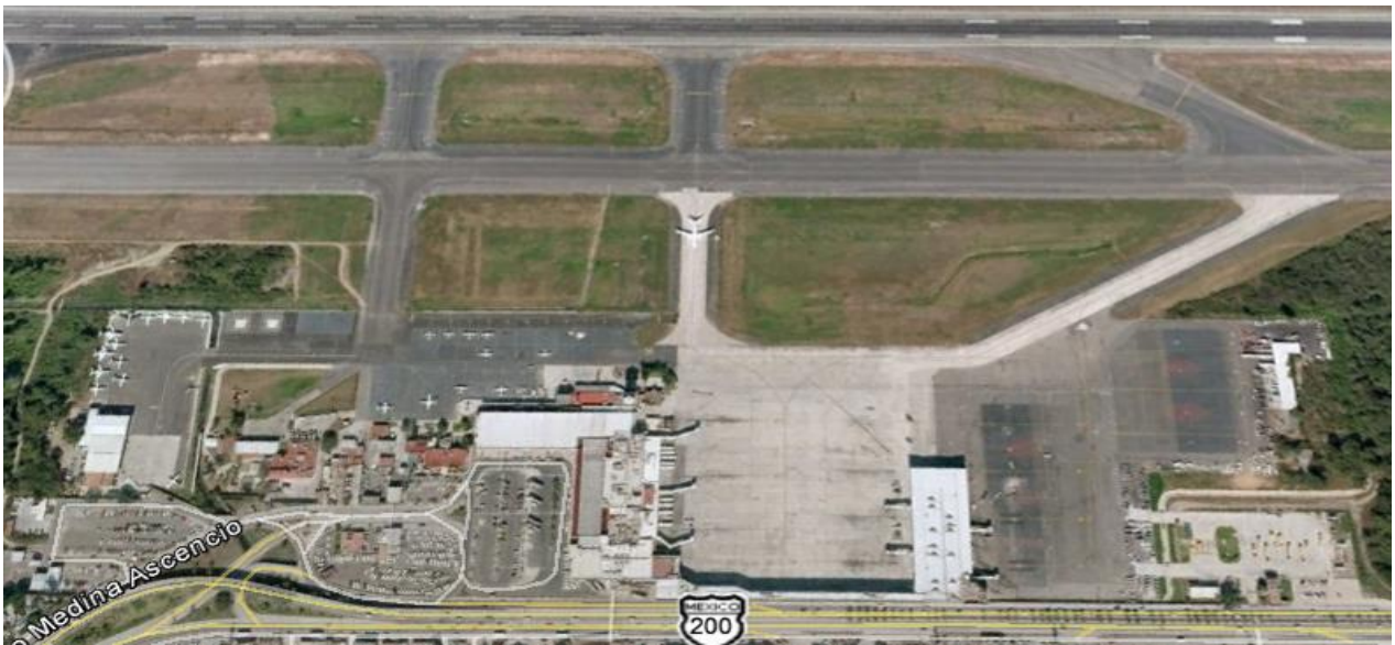
Figura: 1.5 Conjunto Terminales y pista, Fuente: Google Maps.
