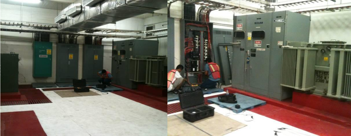
Imagen 3.1, Subestación 1 en planta baja.
