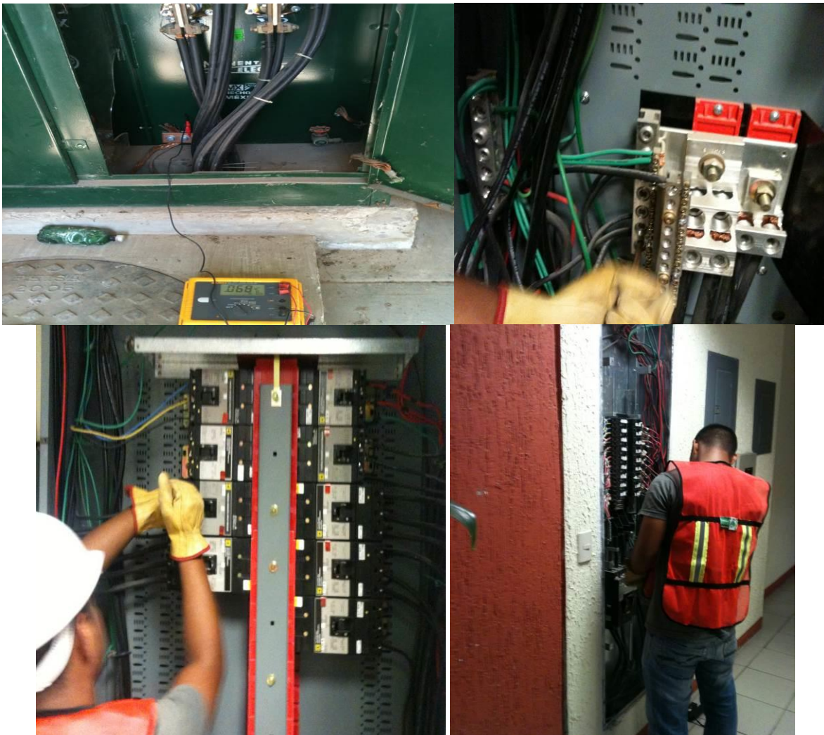
Imágenes 3.28 del interior de las instalaciones en la subestación 1.
