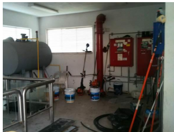
Imagen 3.16 Cuarto de bombas eléctricas.
