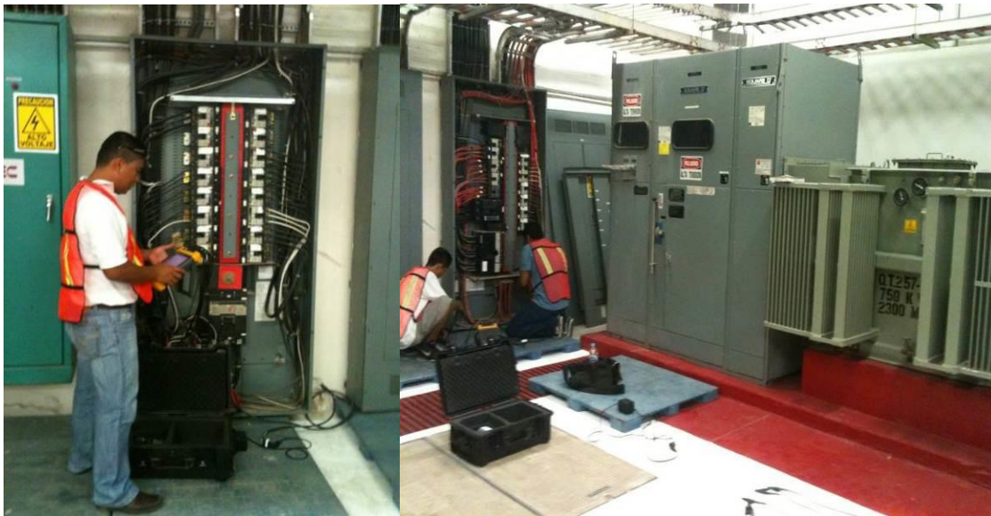
Imagen 3.19 Conexión en tiempo real de analizador en tableros de distribución trifásicos P.B.
