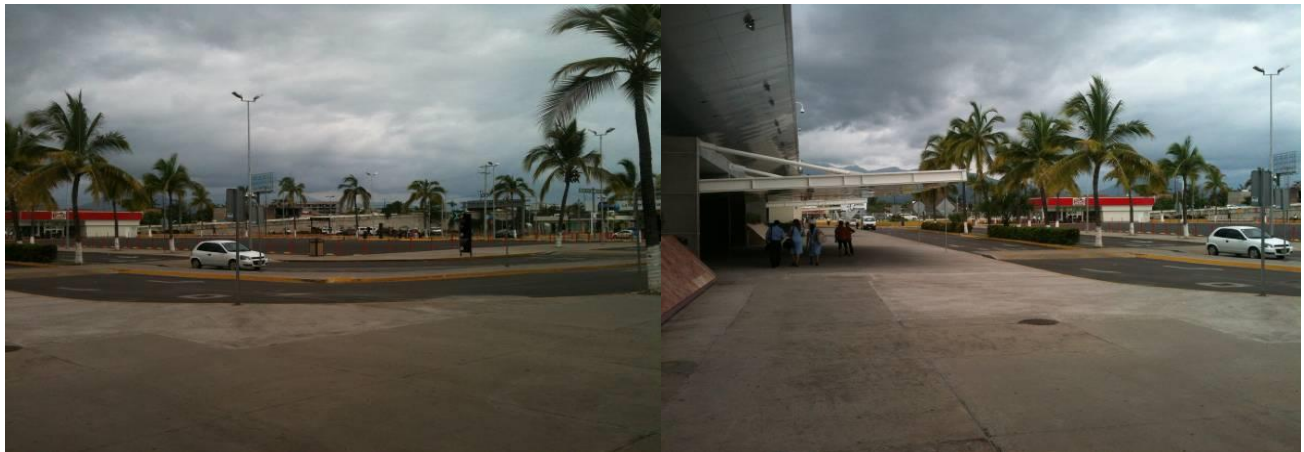
Imagen 3.11 sector estacionamiento para una mejor apreciación de los tipos de las características de luminarias ver anexos.
