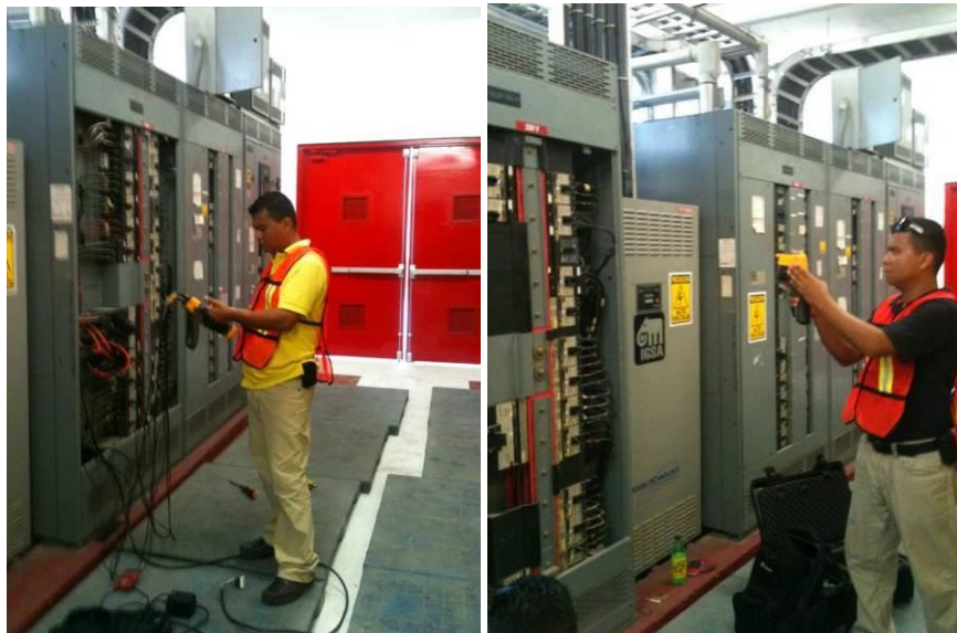
Imagen 3.20 Conexión en tiempo real de analizador en tableros de distribución trifásicos.
