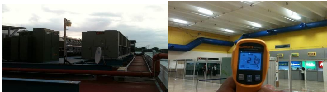
Imagen 3.12 sector Azotea e interiores.
