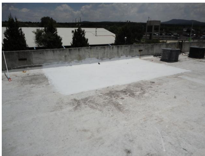
Fig. 83 Aplicación de impermeabilizante color blanco.
