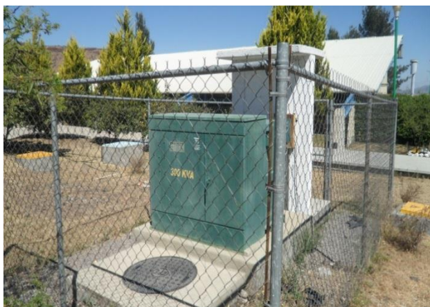
Fig. 13 Transformador 300KVA
