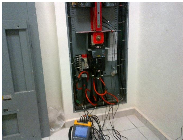
Fig. 63 Equipo conectado en Edificio "E"
