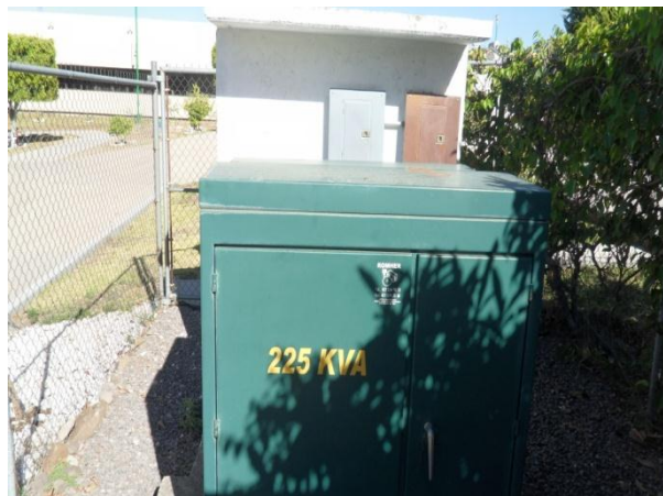
Fig. 16 Transformador 225KVA
