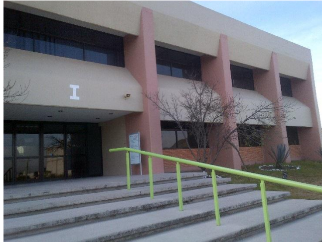
Fig. 44 Entrada Principal Edificio "I"
