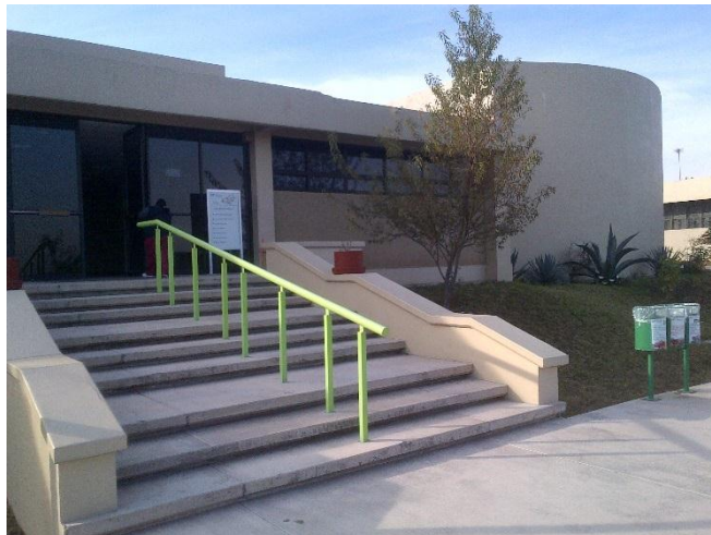
Fig. 62 Entrada Principal Edificio "E"
