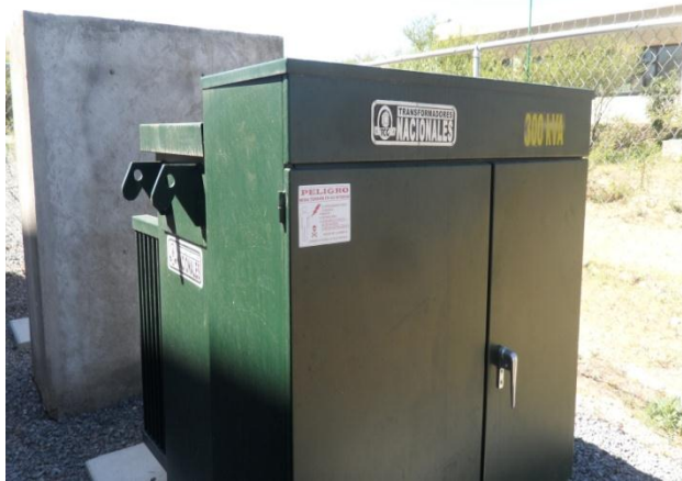
Fig. 14 Transformador 300KVA
