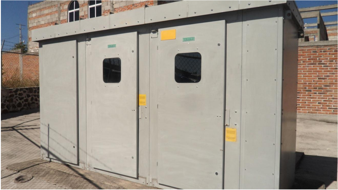
Fig. 11 Subestación receptora UTSJR
