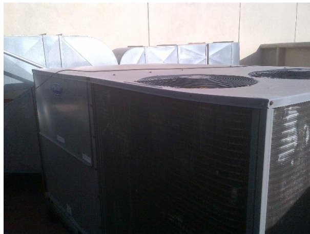
Fig. 64 Equipo A/C 5 Toneladas
