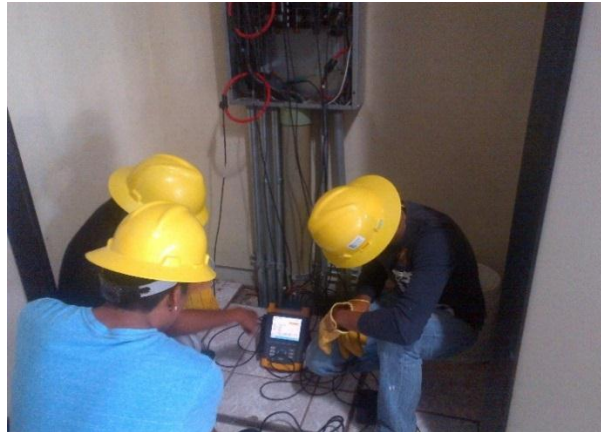
Fig. 39 Equipo Conectado Edificio N
