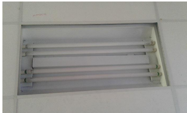
Fig. 72 Sistema Actual de iluminación en salones
