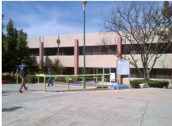
Fig. 34 Entrada Principal Edificio "J"
