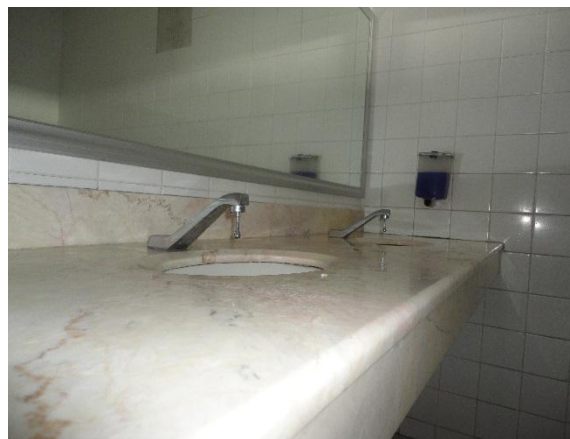
Fig. 79 Válvulas Ahorradoras Instaladas.
