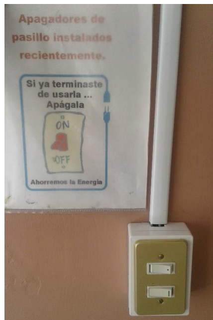
Fig. 82 Implementación de apagadores accesibles y seccionados de circuitos.
