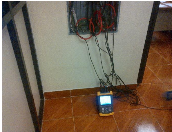
Fig. 53 Equipo conectado en Edificio "H"
