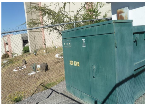
Fig. 12 Transformador 300KVA, EMSA
