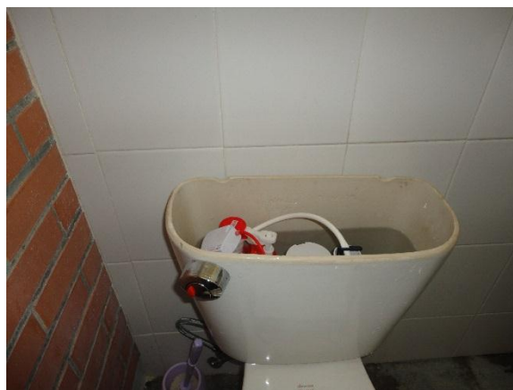
Fig. 78 Sistema Dual en WC.
