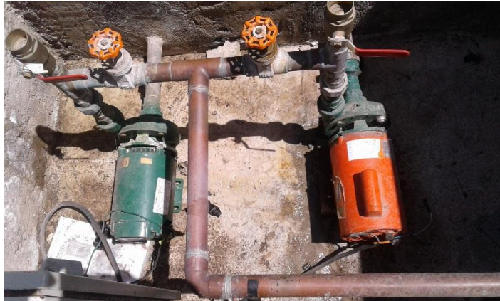
Fig. 76 Bombas Hidráulicas, 3/4 Hp.
