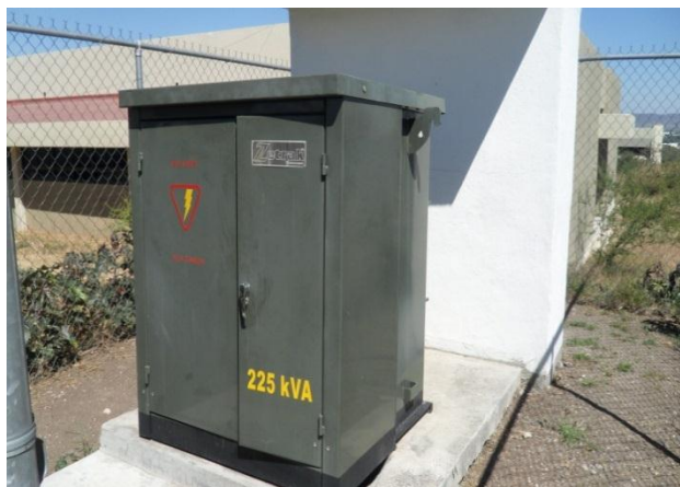
Fig. 15 Transformador 225KVA
