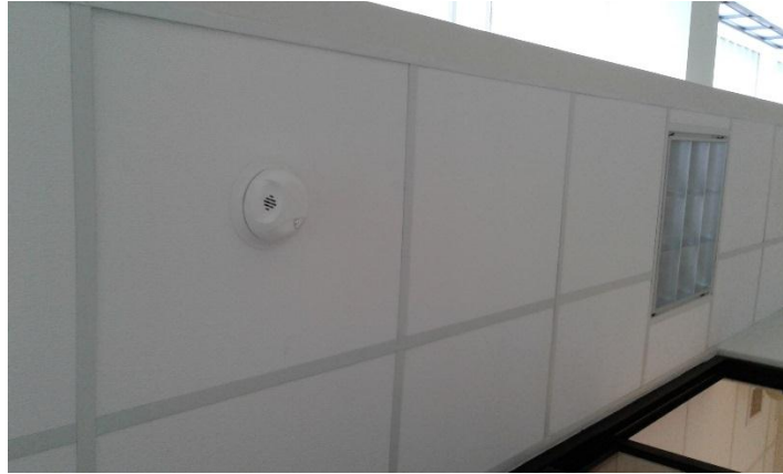
Fig. 80 Sensores de Movimiento Instalados.
