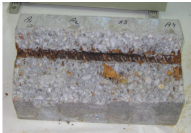
Figura 2.2 Estructura de Concreto Armado altamente dañado por la corrosión.
