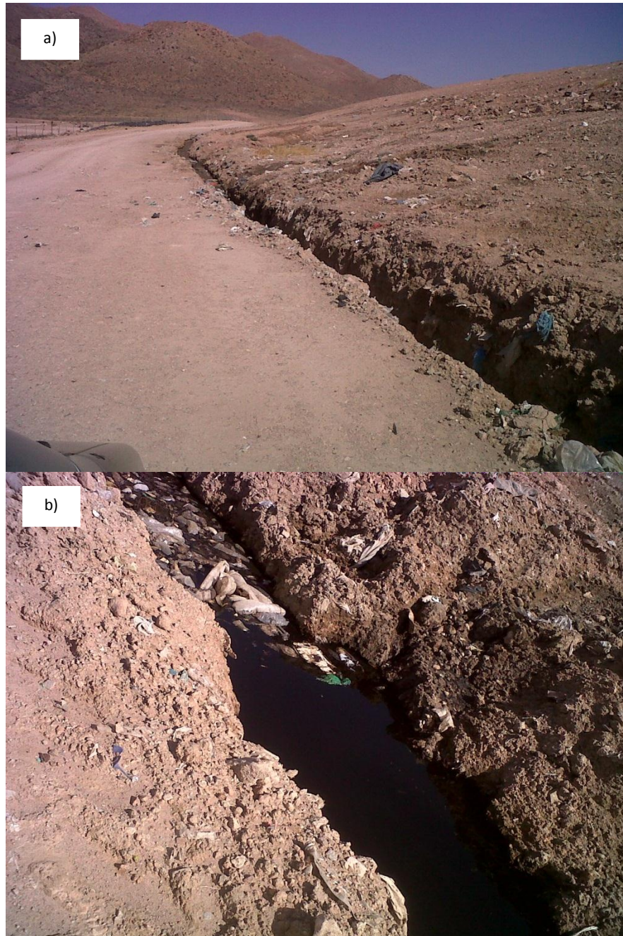
Figura 11. Canal de lixiviados. a) Vista desde el camino para el tránsito de vehículos b) Vista ampliada del canal
