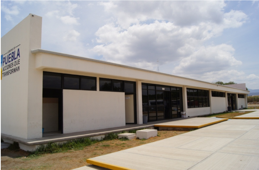
Fig. 50 Parte frontal del edificio de electromecánica industrial vista hacia el sureste.
