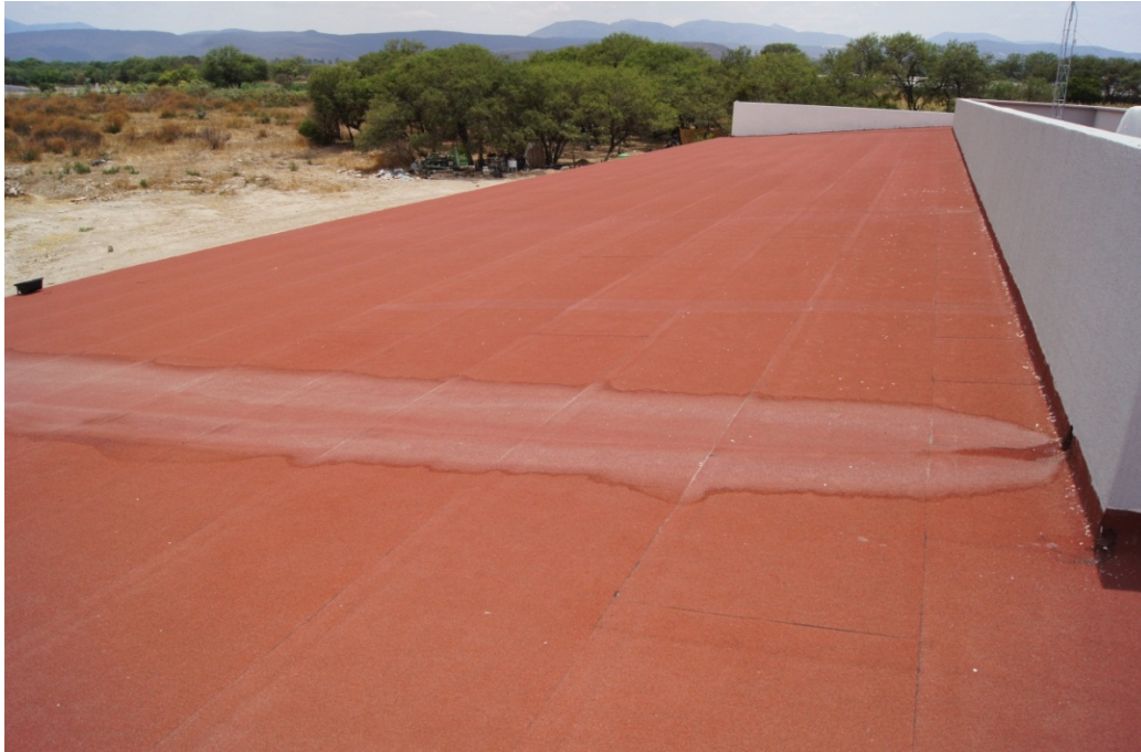
Fig. 52 Lado Sur del techo del edificio en donde se colocarán los paneles solares.
