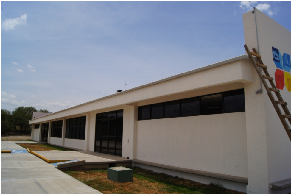
Fig. 51 Parte frontal del edificio de electromecánica industrial vista hacia el noreste.
