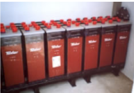
Fig. 29 Colocación de las baterías.
