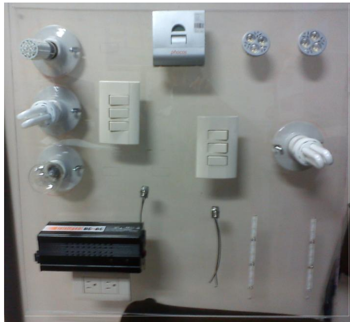
Figura 31. Módulo de prácticas fotovoltaico terminado
