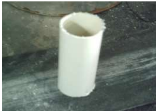
Figura 21. Corte y limpieza del tramo de PVC.
