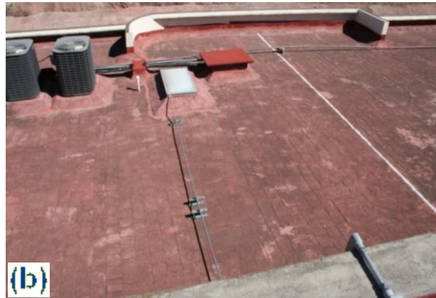
Fig. 2.11 Protección del cableado en tubería de acero galvanizado (a) saliendo de los paneles fotovoltaicos y (b) al ingreso al inversor que se encuentra a la entrada del edificio.
