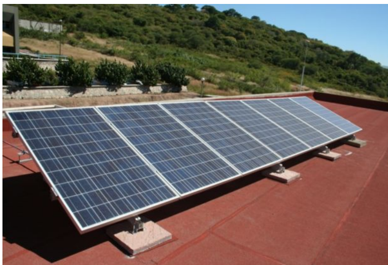
Fig. 3.2 Panel SILIKEN de 245 W nominales utilizado en el PVS.
