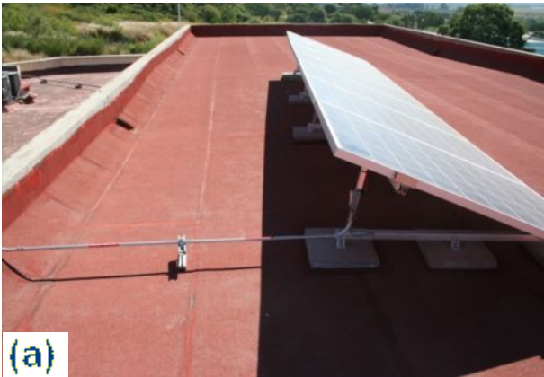
Fig. 2.11 Protección del cableado en tubería de acero galvanizado (a) saliendo de los paneles fotovoltaicos y (b) al ingreso al inversor que se encuentra a la entrada del edificio.
