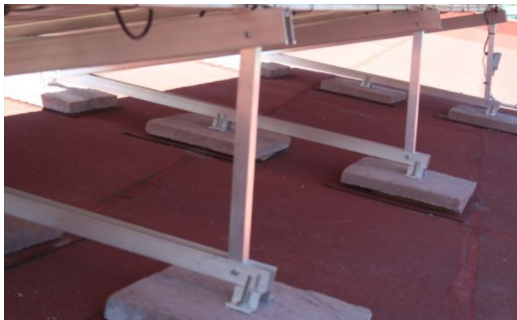
Fig. 2.8.- Instalación de lastres para sujetar la estructura al piso.
