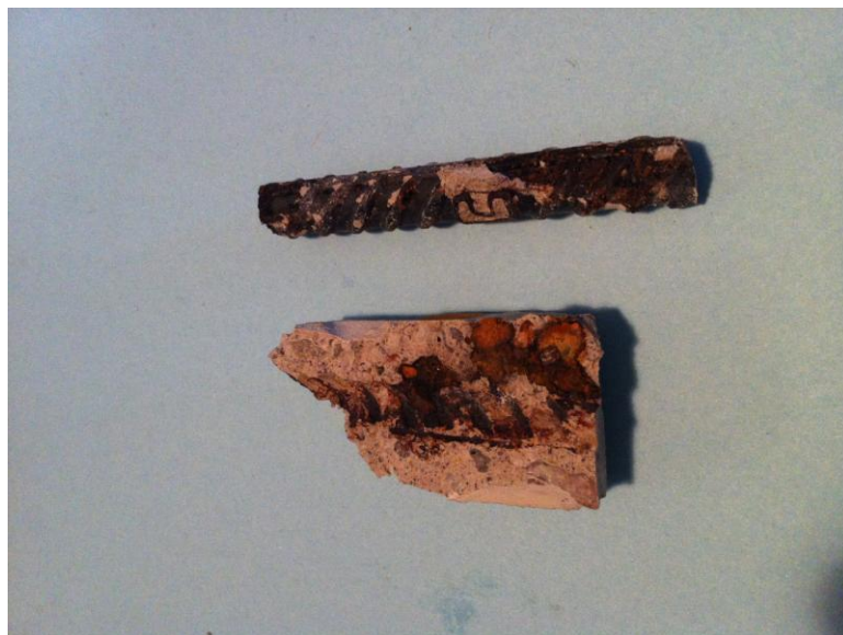
Figura 25. Elemento de acero de refuerzo sin corrosión inicial proveniente de una probeta de concreto simple (SS).
