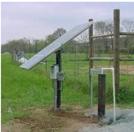
Fig.8 sistema de bombeo rural energizado con una celda solar
