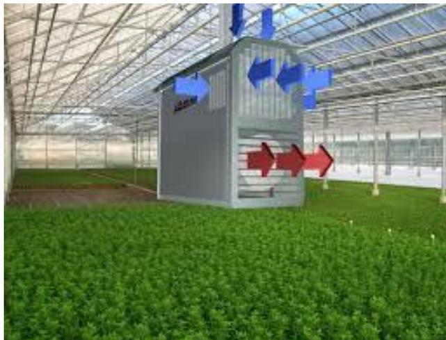
Figura 4. 1.- Ejemplo de un sistema de calefacción por aire de un invernadero.
