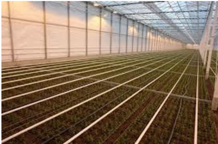
Figura 4. 2.- Ejemplo de un sistema de distribución de calor por tubos con agua caliente.
