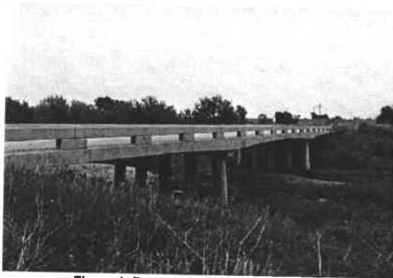
Figura 1. Puente de concreto reforzado.
