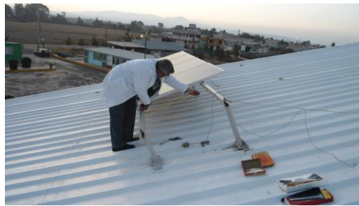
Figura 16. Fijación de paneles solares en la estructura
