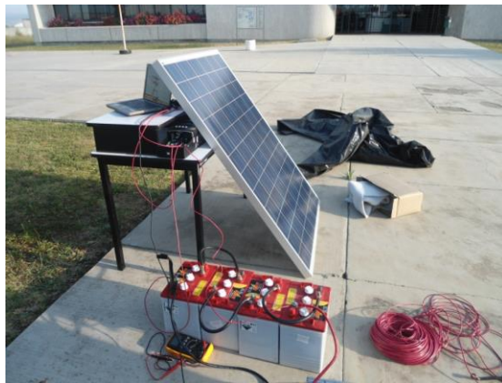
Figura15. Pruebas de sistema fotovoltaico
