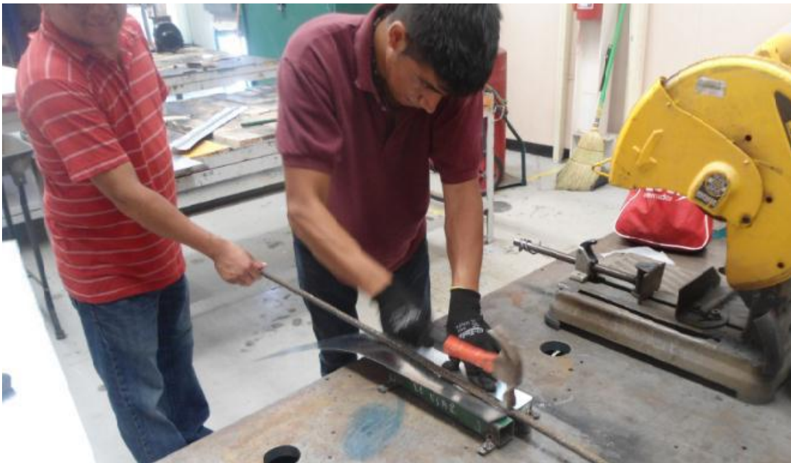
Construcción de la cubierta de lámina galvanizada
