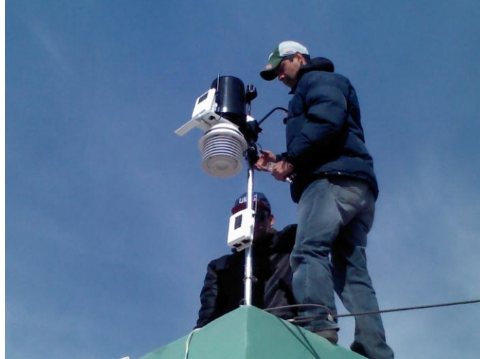
Instalación de la estación meteorológica
