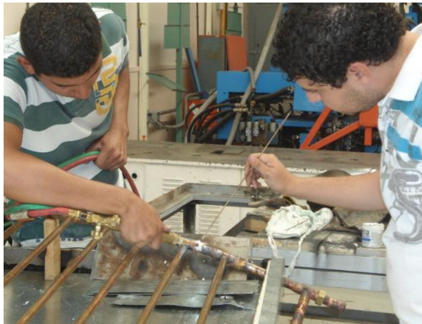
Tapado de fugas de agua
