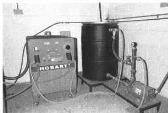
Figura 2-4. Fuente de poder y sistema de enfriamiento.
