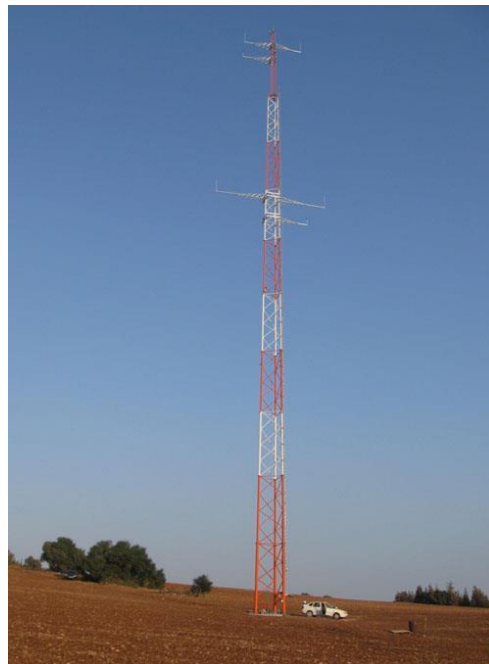
Figura 3.1 Sensores a diferentes alturas en una estación
