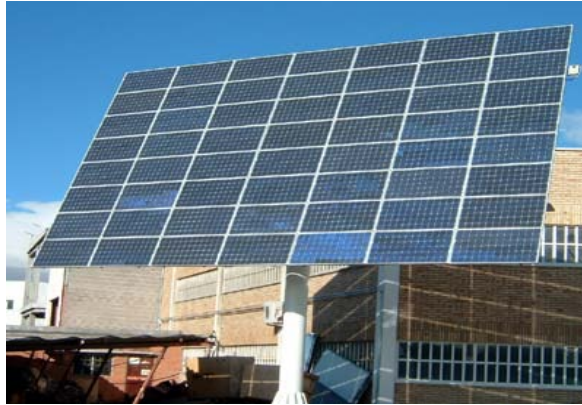
Figura 2. 2. Seguidor solar de dos ejes
