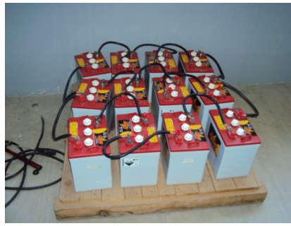
Figura 13. Arreglo de baterías en paralelo
