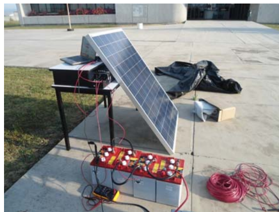
Figura15. Pruebas de sistema fotovoltaico
