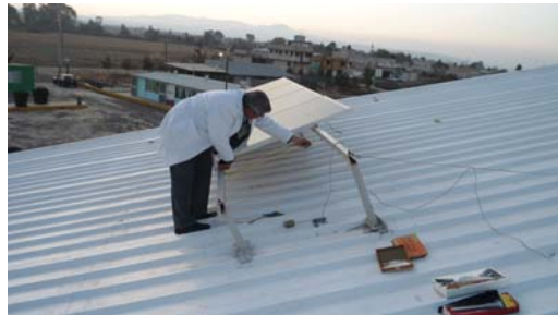
Figura 16. Fijación de paneles solares en la estructura
