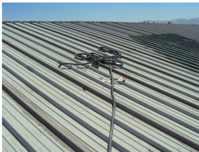
Figura 17. Canalización y cableado.
