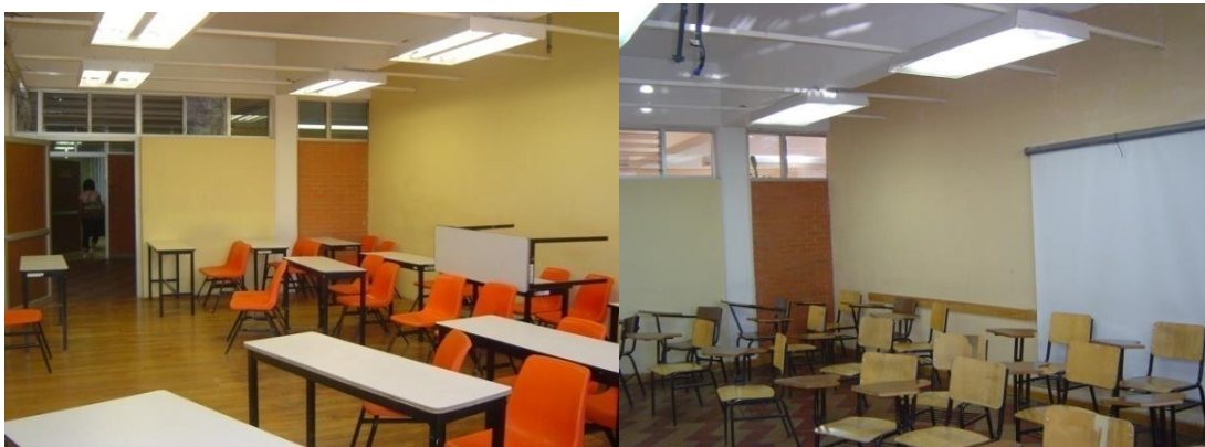
Figura 43. Imágenes que muestran el estado actual de las luminarias, después de aplicar el recubrimiento reflejante en los gabinetes.
