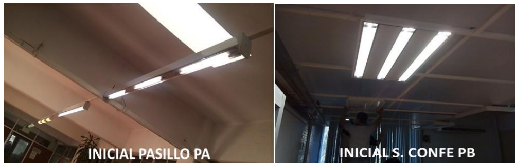
Figura 55. Imágenes del estado inicial antes de la sustitución de luminarias en pasillo planta alta y sala de conferencias de la planta baja.
