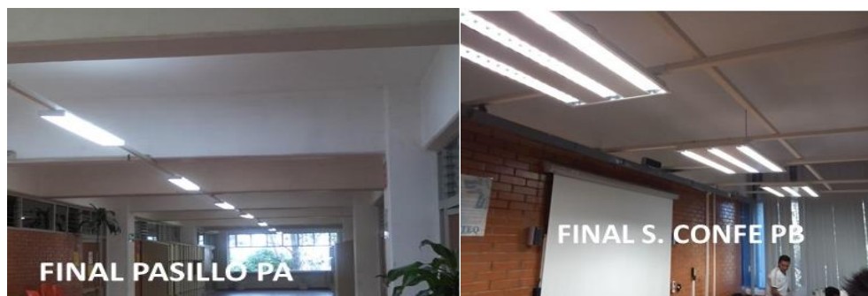
Figura 56. Imágenes del estado final después de la sustitución de luminarias en pasillo planta alta y sala de conferencias de la planta baja.
