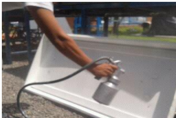
Figura 38. Imágenes de algunos de los materiales reflejantes aplicados: pintura de cromo, papel reflejante y barniz de poliuretano.
