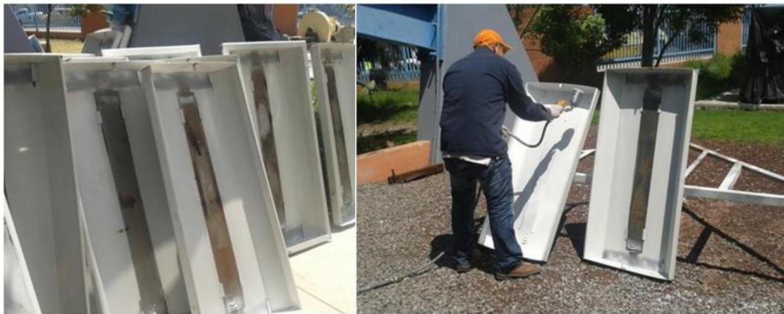
Figura 47. Limpieza y aplicación del acabado reflejante en los gabinetes.
