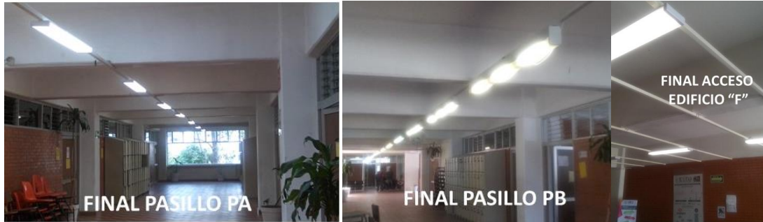
Figura 57. Lugares donde se realizaron trabajos de sustitución de luminarias.
