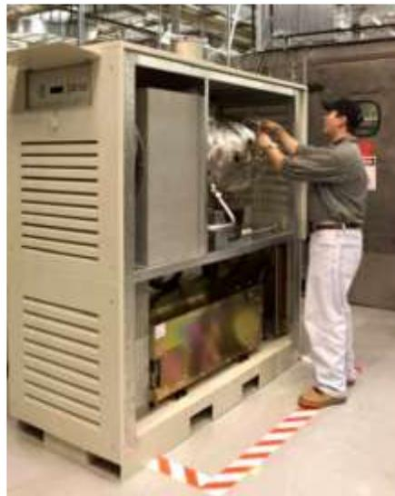
Fig. 44 Imagen ilustrativa de mantenimiento programado a una microturbina.
