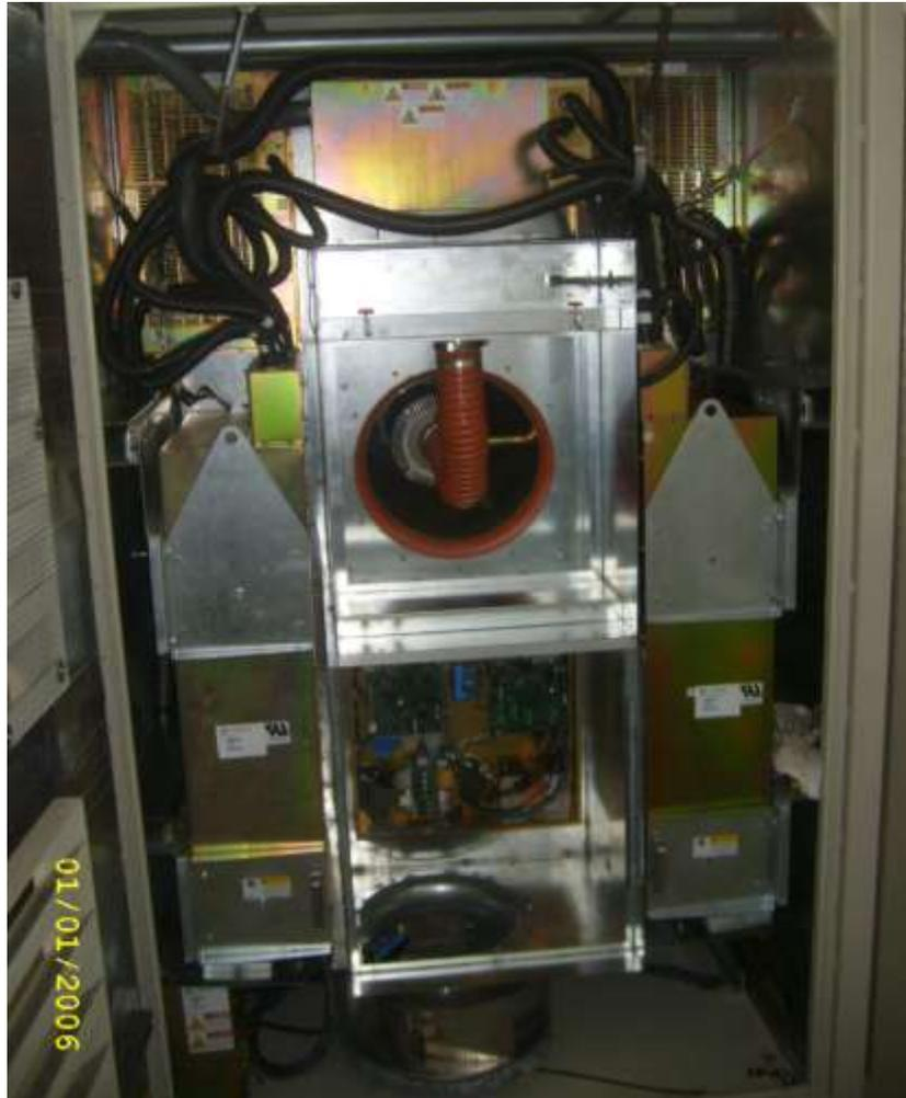
Fig. 41 Fotografía lado entrada de aire de la microturbina Capstone.
