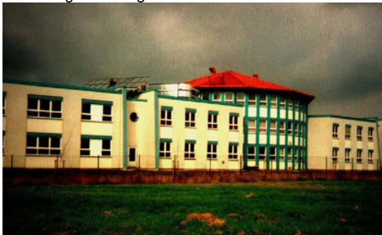
Fig. 23. Sistema de aire acondicionado solar con desecante instalado en Riesa, Alemania (Russ, 2003).
