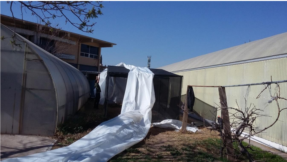
Figura 3-22 Instalación del hule de invernadero
