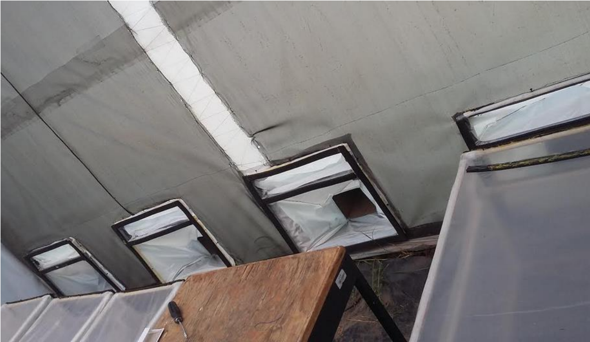
Figura 3-25 Instalación de microtúneles
