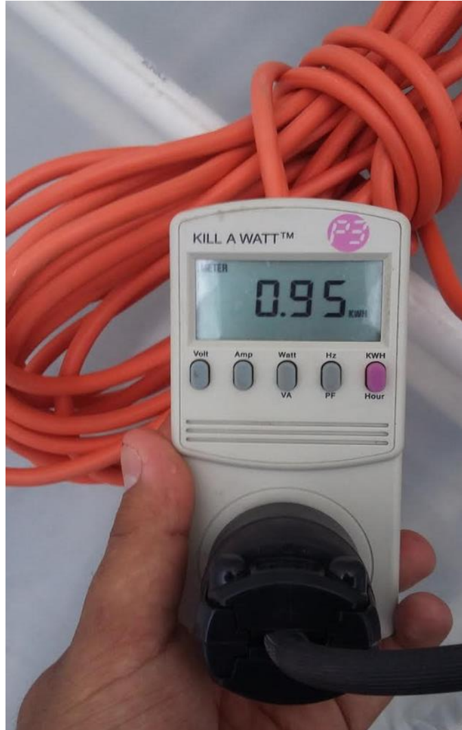
Figura 4-2 Medición de la energía eléctrica consumida por el sistema de ventilación
