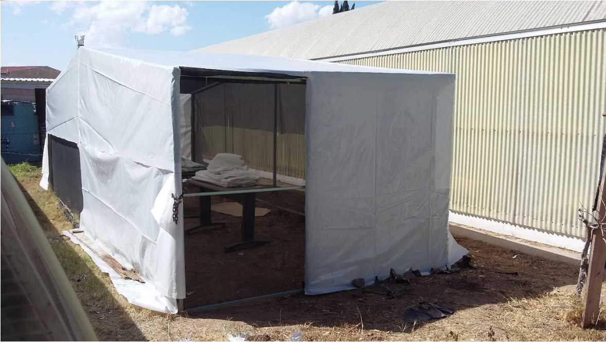
Figura 3-23 Instalación del hule en el invernadero
